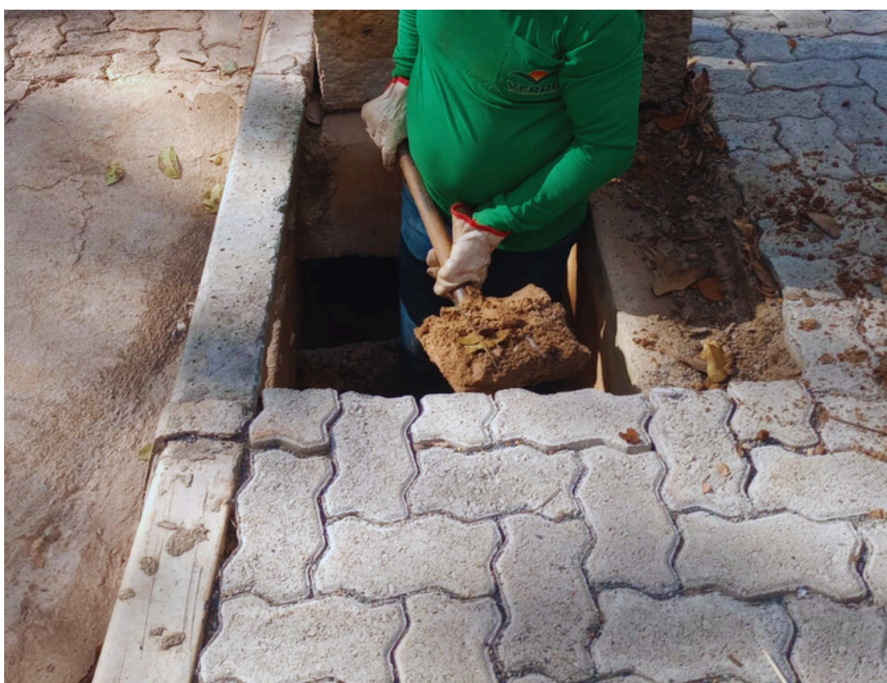
Limpeza das bocas de lobos e manutenção das grelhas
