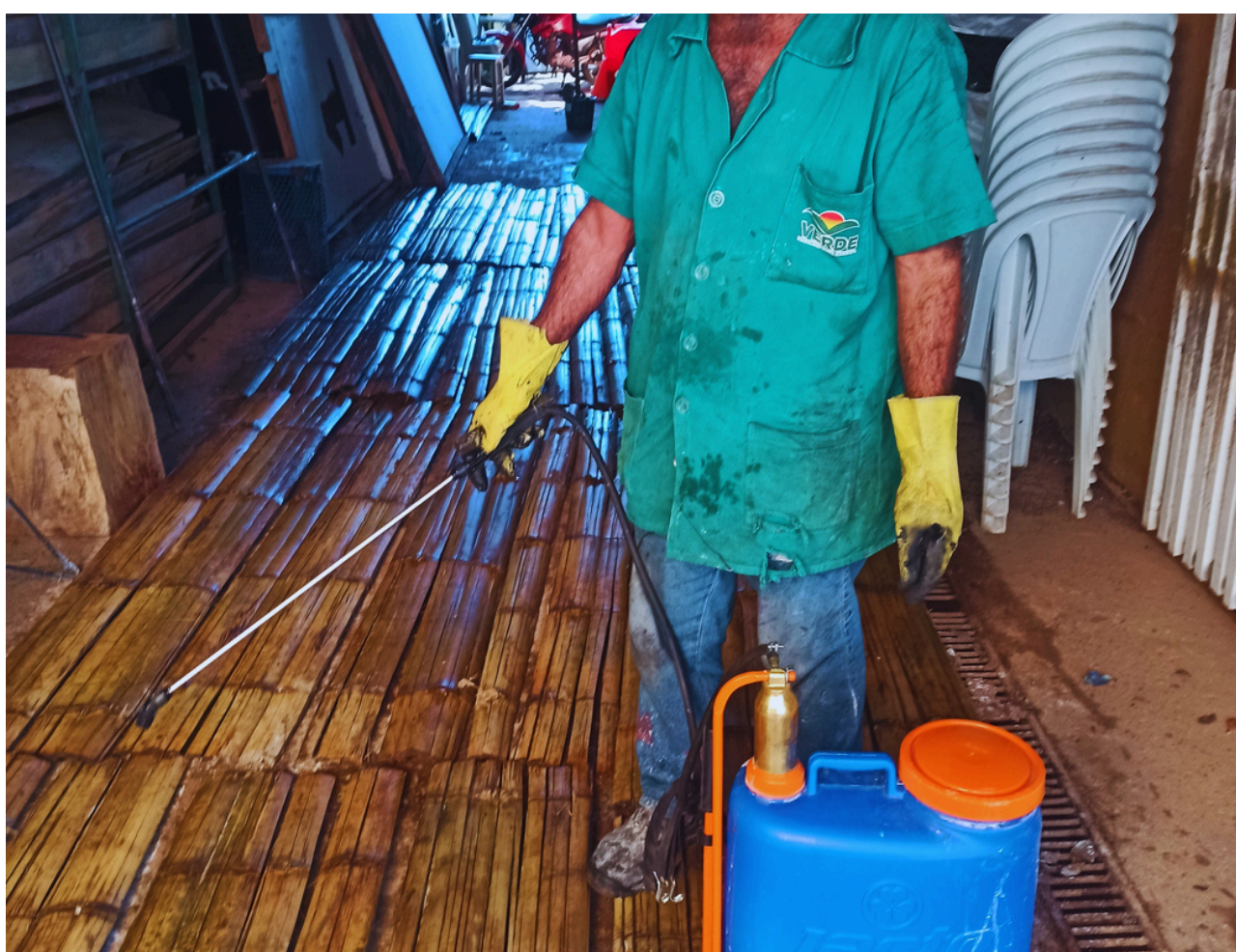
Tratamento dos bambus para a cobertura do palco Espaço Nave
