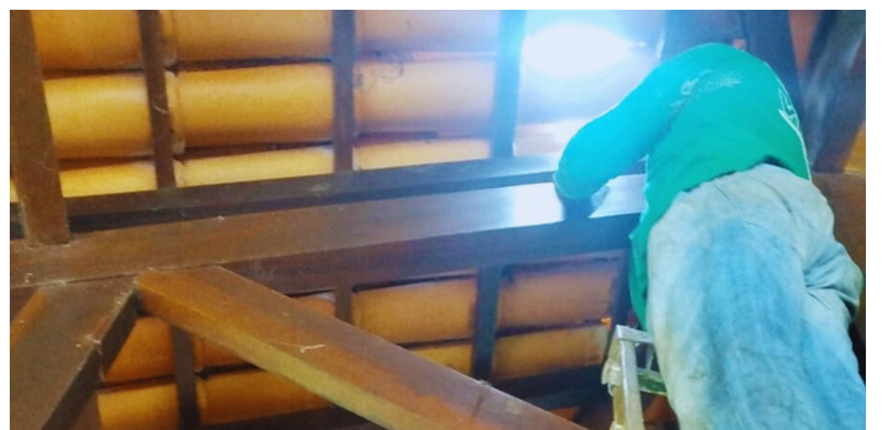
Troca das telhas do salão de festas
