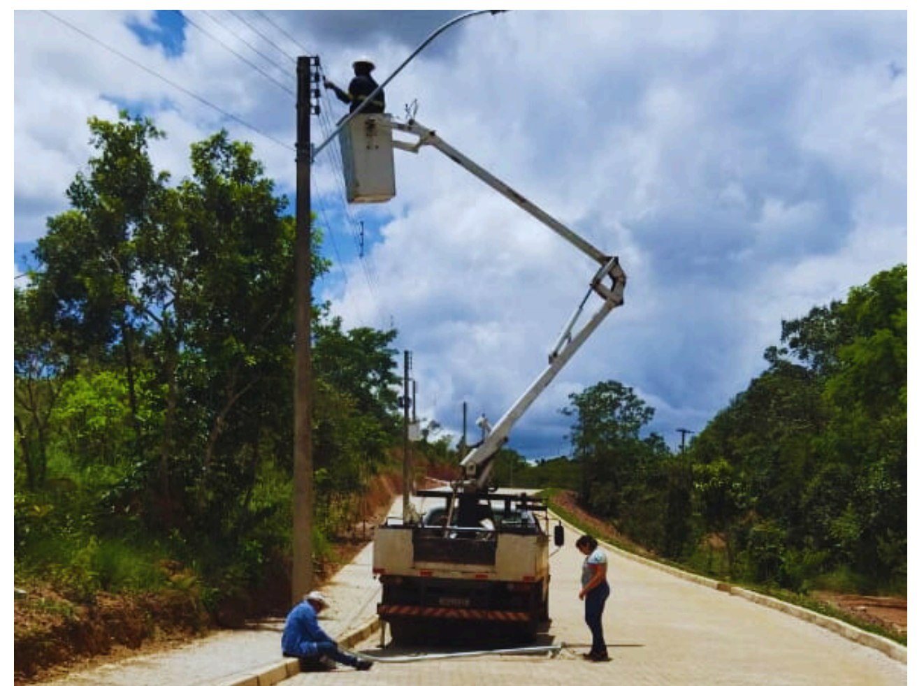
Instalação das novas luminárias de LED nas ruas Azaleias e Bromélias
