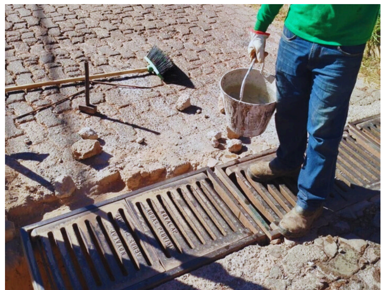
Manutenção das grelhas
