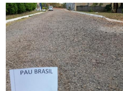
Figura 19: Rua Pau Darco
